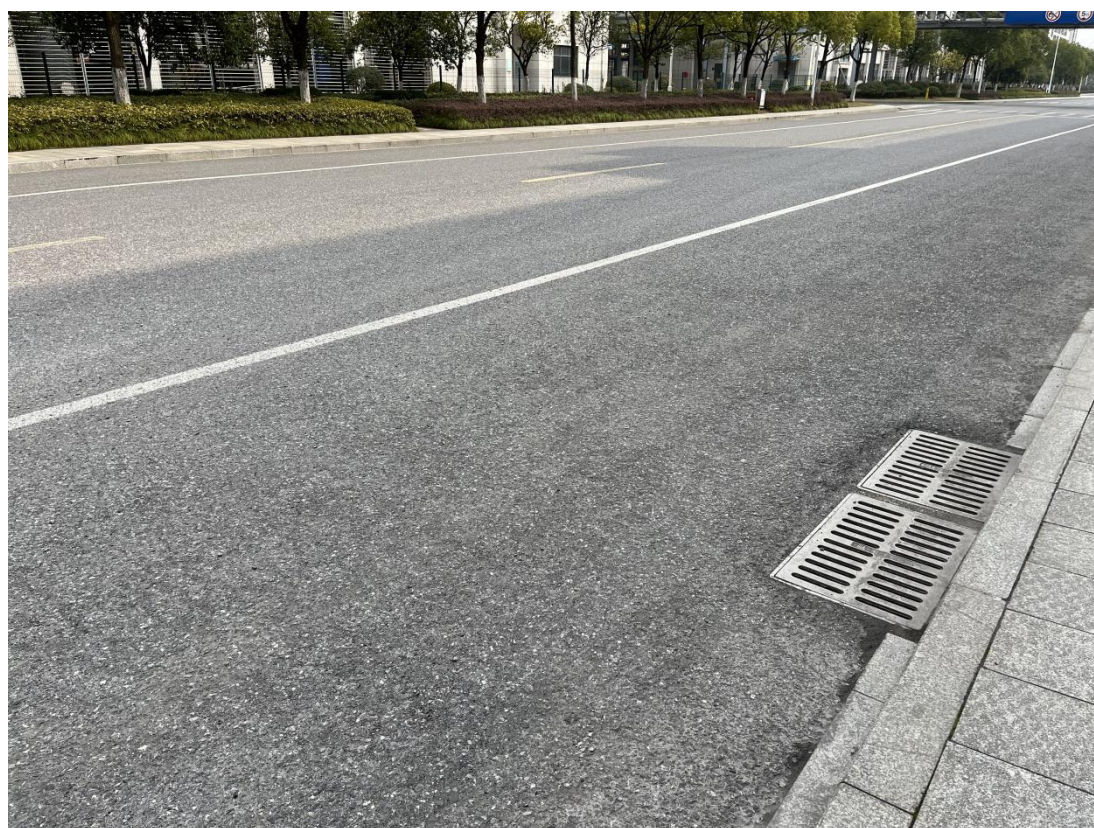
项目区内雨污管网现状
