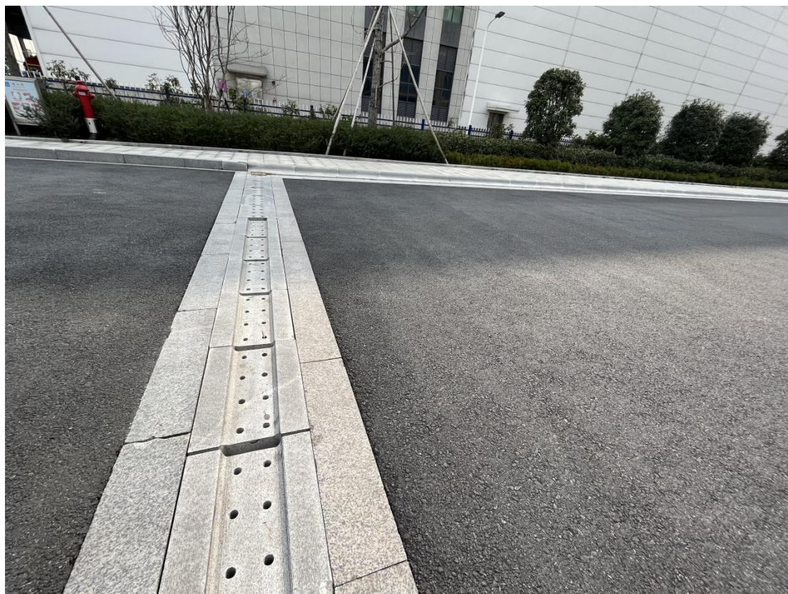
项目区内雨水排水现状
