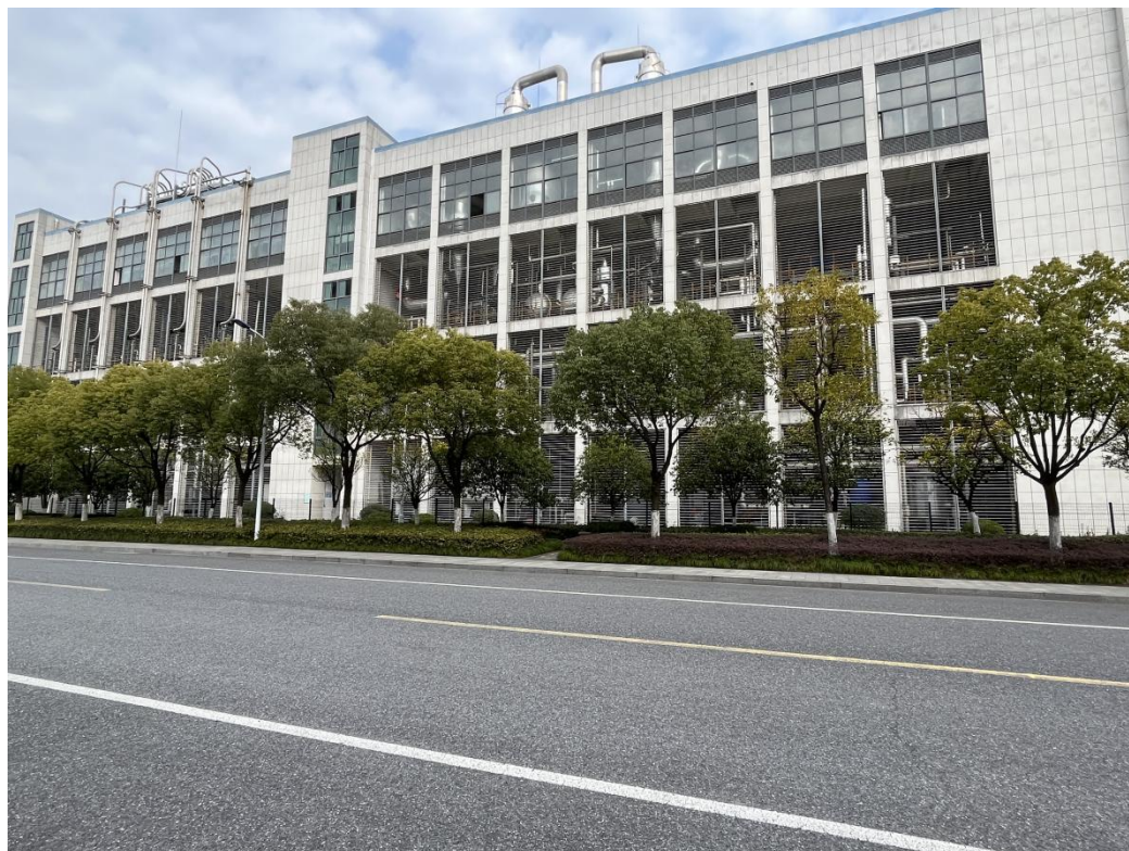
项目主体建设现状 2
