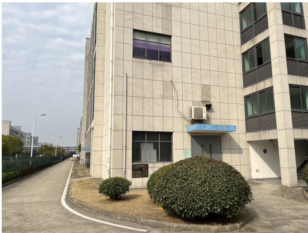
项目主体建设现状 1
