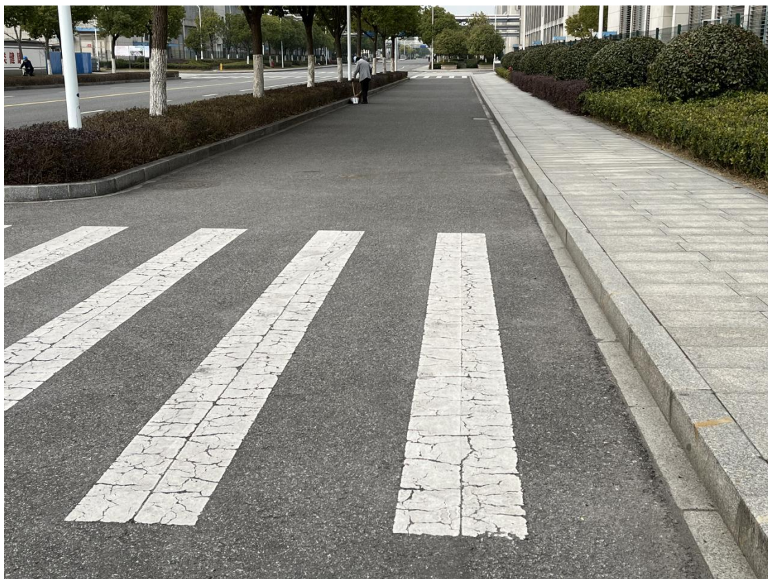
项目道路硬地现状 1
