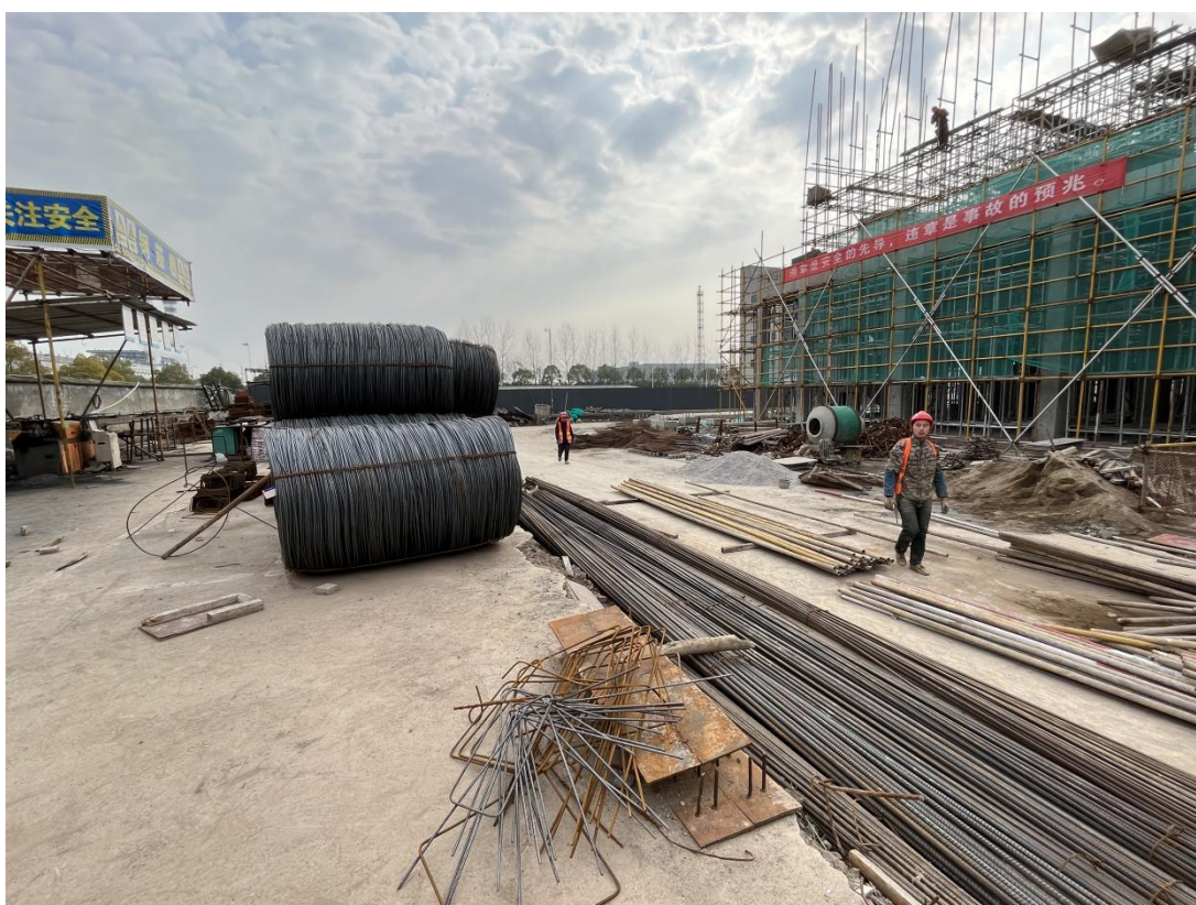
项目区施工场地现状 2
