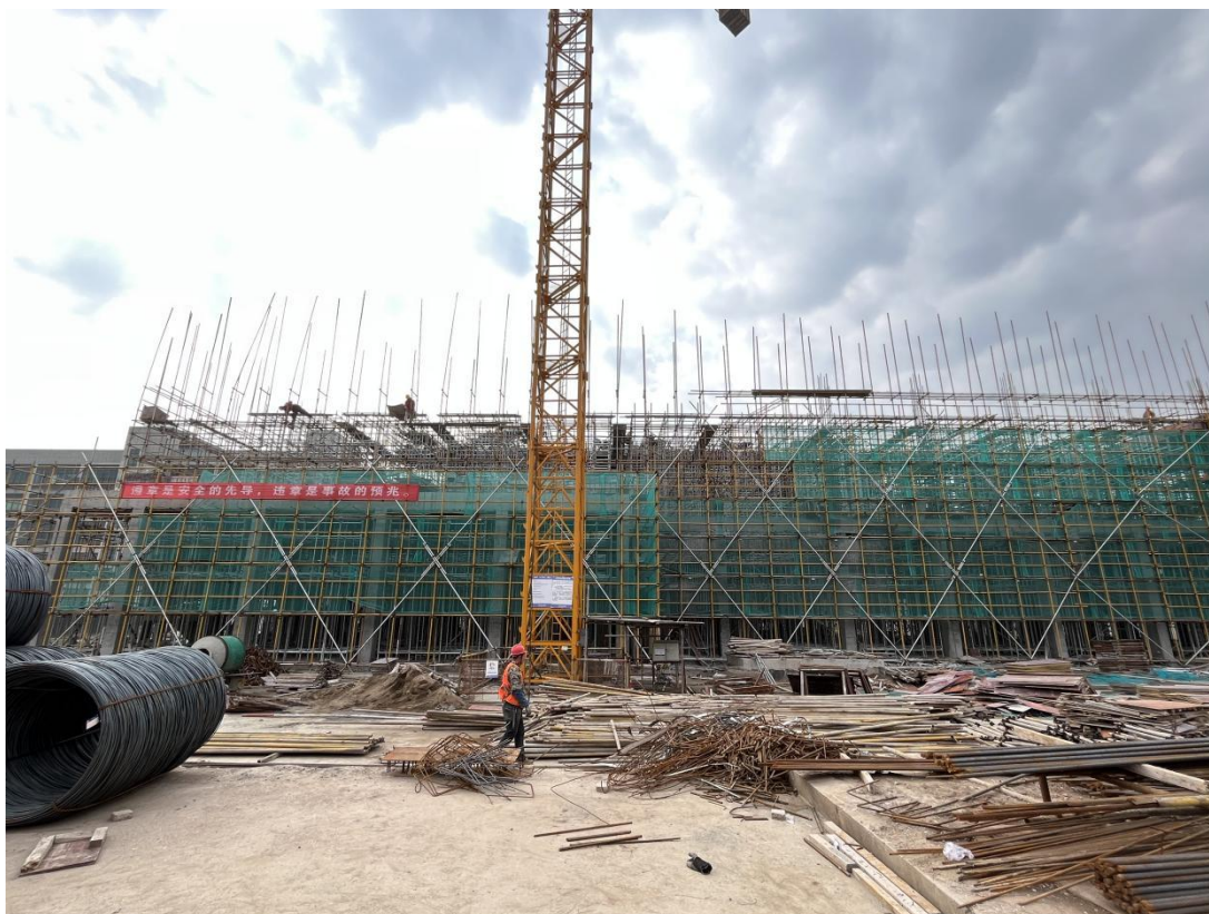
项目区施工场地现状 1
