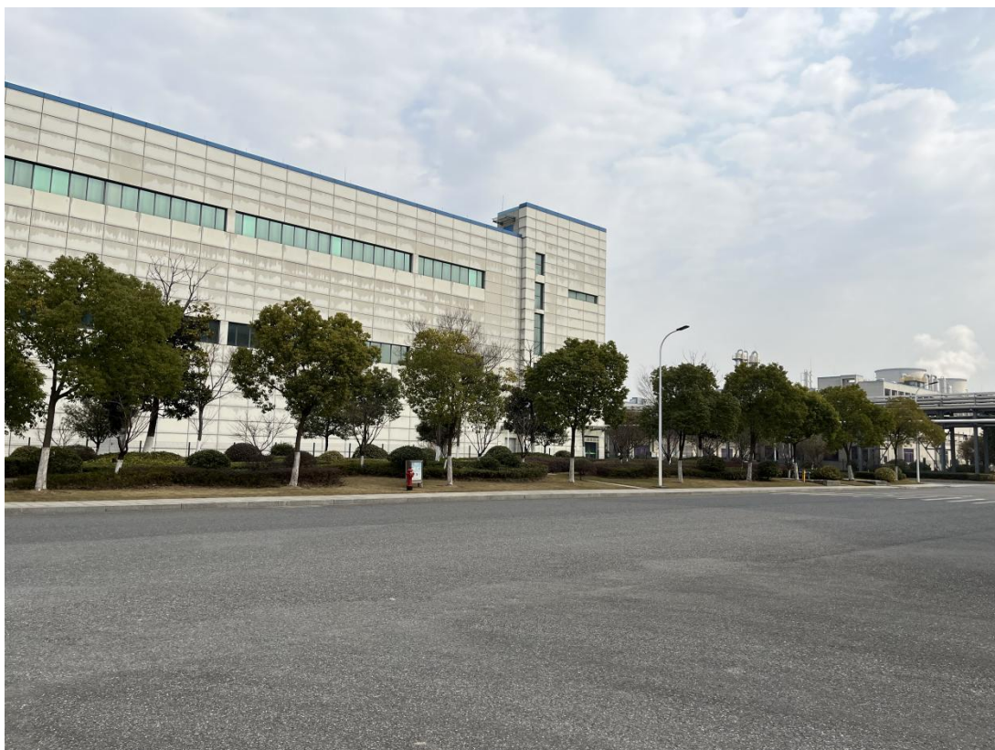
项目道路硬地现状 2
