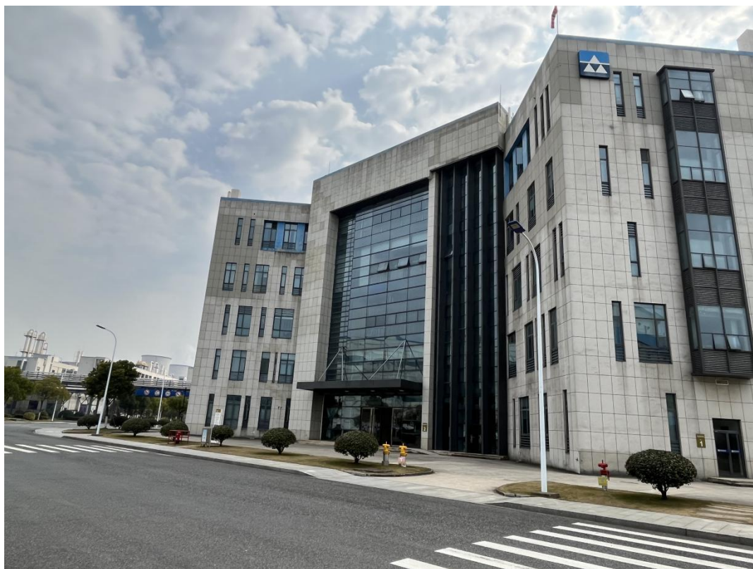
项目主体建设现状 1
