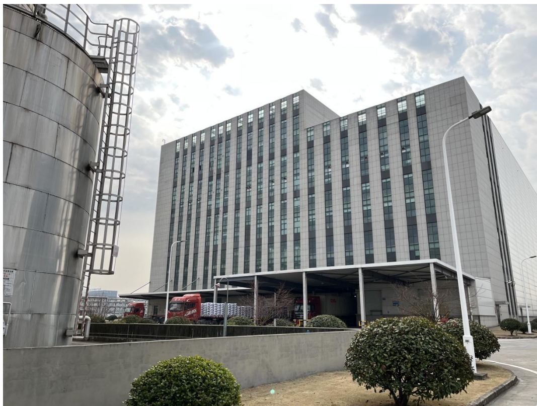
项目主体建设现状 2
