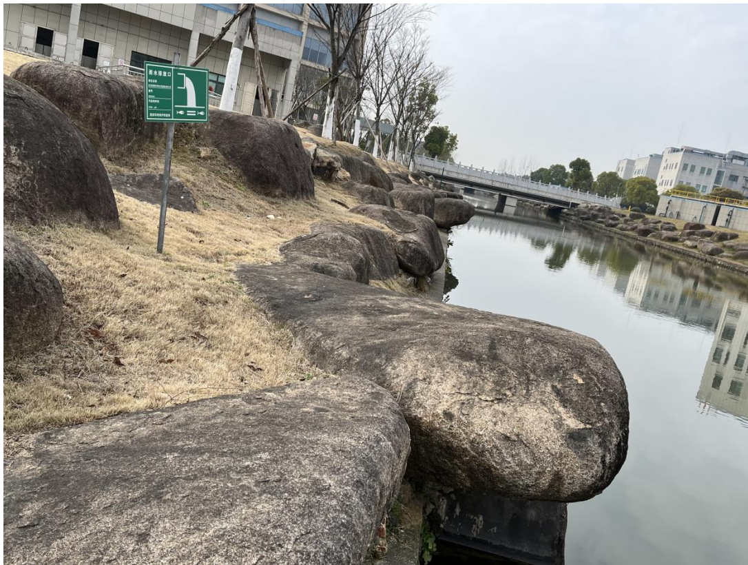
项目区内雨水排水现状（雨水排放口）
