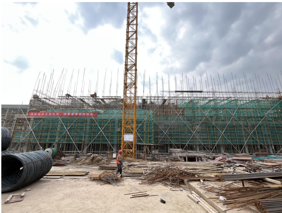
项目区施工场地现状
