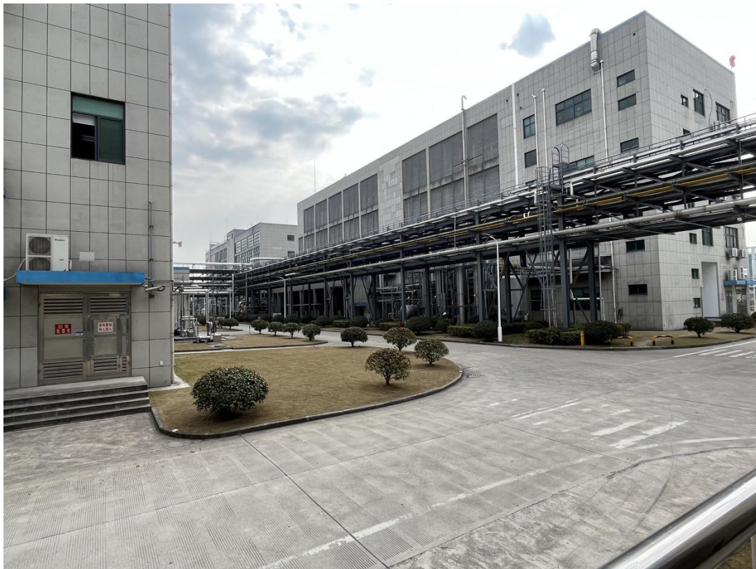
项目道路硬地现状 1
